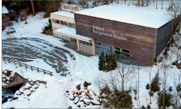
Die Stätte der Stromproduktion: das E-Werk Bergkristall-Stießer.
