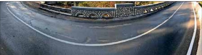
Die Arbeiten im Bereich der Koflerbrücke sind abgeschlossen. Straßendienst
