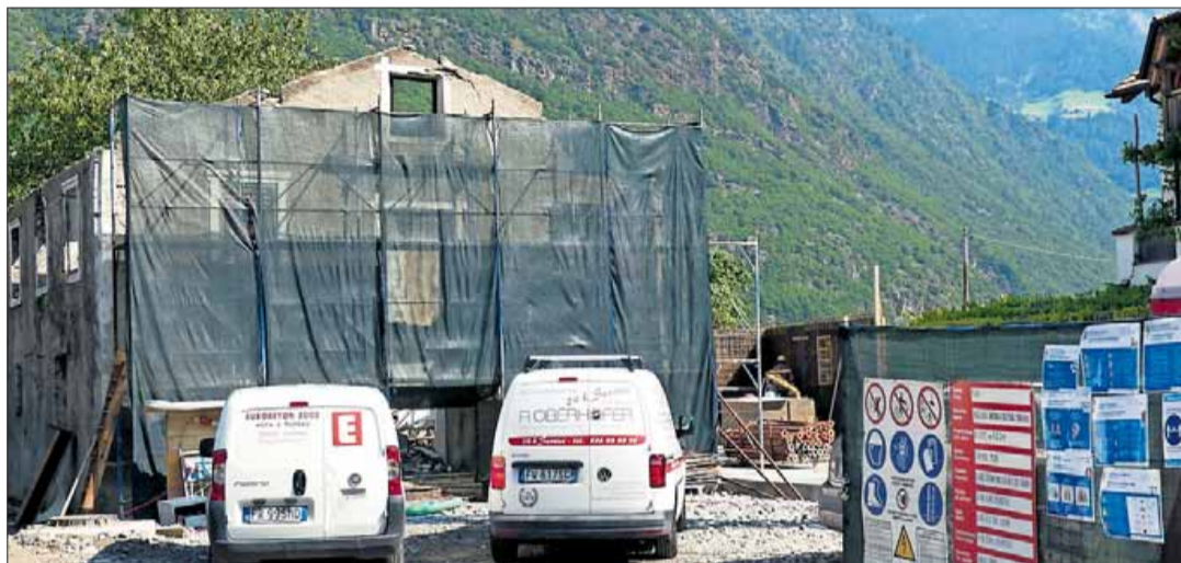
Das Dach des Pixnerhauses wurde abgebrochen und eine Mauer eingerissen, um den Zubau (rechts hinten) zu errichten, für den bereits das Fundament gegossen wurde.
