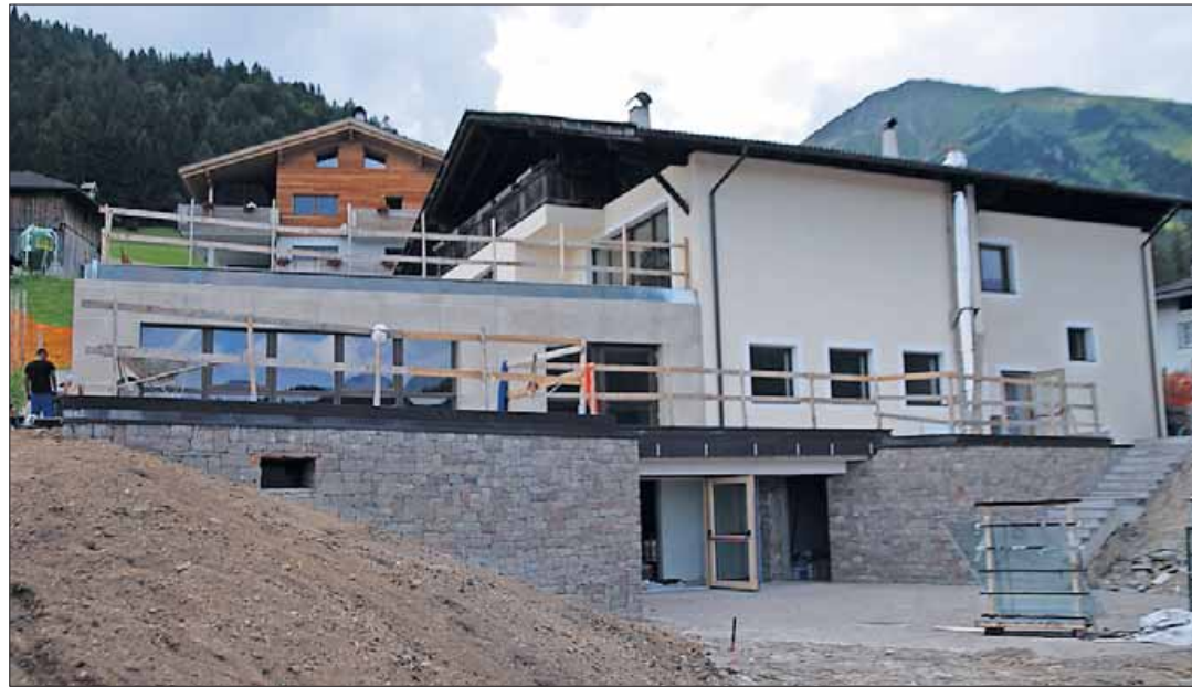
Die Arbeiten an der Grundschule und an der Turnhalle mit Mehrzweckfunktion schreiten voran.
