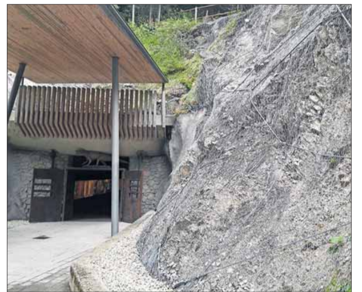
Die Felssicherungsarbeiten im Eingangsbereich sind abgeschlossen. fm
