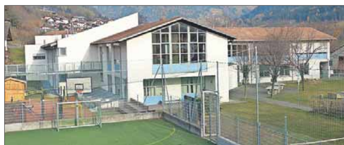
Die Mittelschule in St. Martin wird im Sommer 2018 energetisch saniert. ehr
