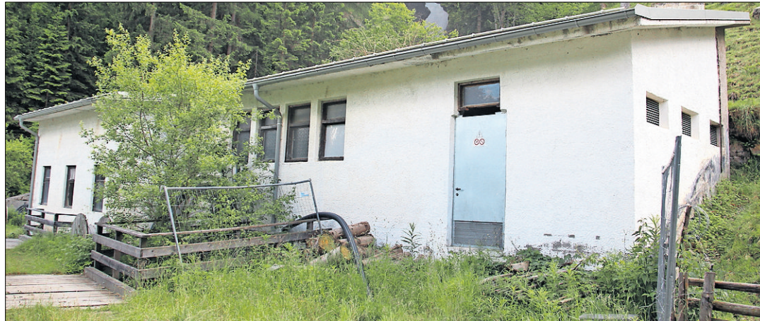
Das alte E-Werk Moos wird in ein Museum umgestaltet.
